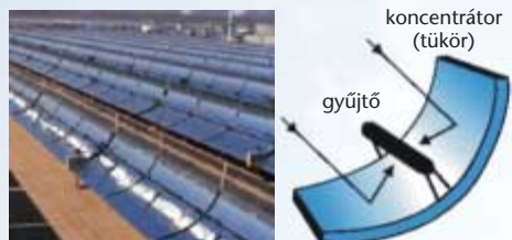
4. ábra. Napteknő (354 MW) a kaliforniai Mojave sivatagban ( http://www1.eere.energy.gov/solar/csp.html )
